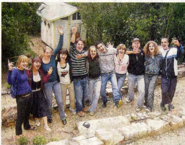
Drei Wochen lang haben die Jugendlichen aus aller Welt gerodet, geschaufelt und Steine geschleppt. Voller Stolz freuen sie sich über die fertig gestellte Kräutermauer. Foto: Strauß
